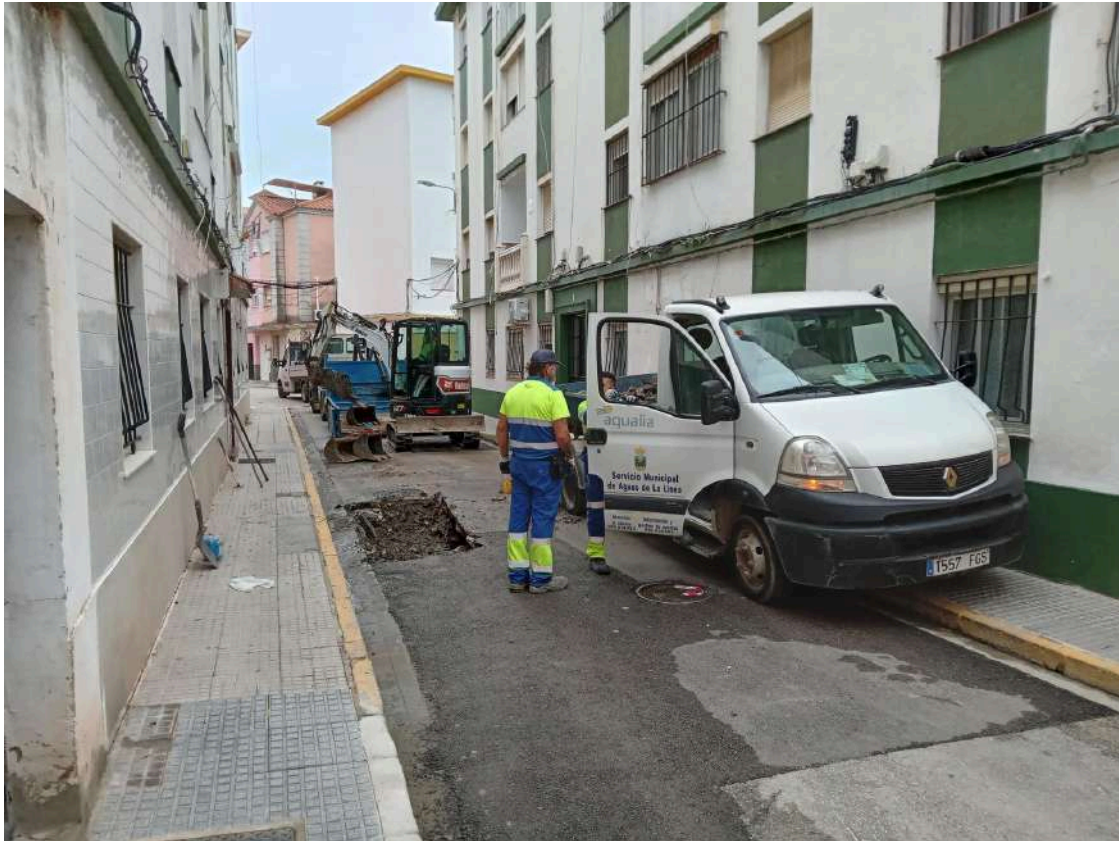
Obras en la red de aguas de La Línea. / E. S.
