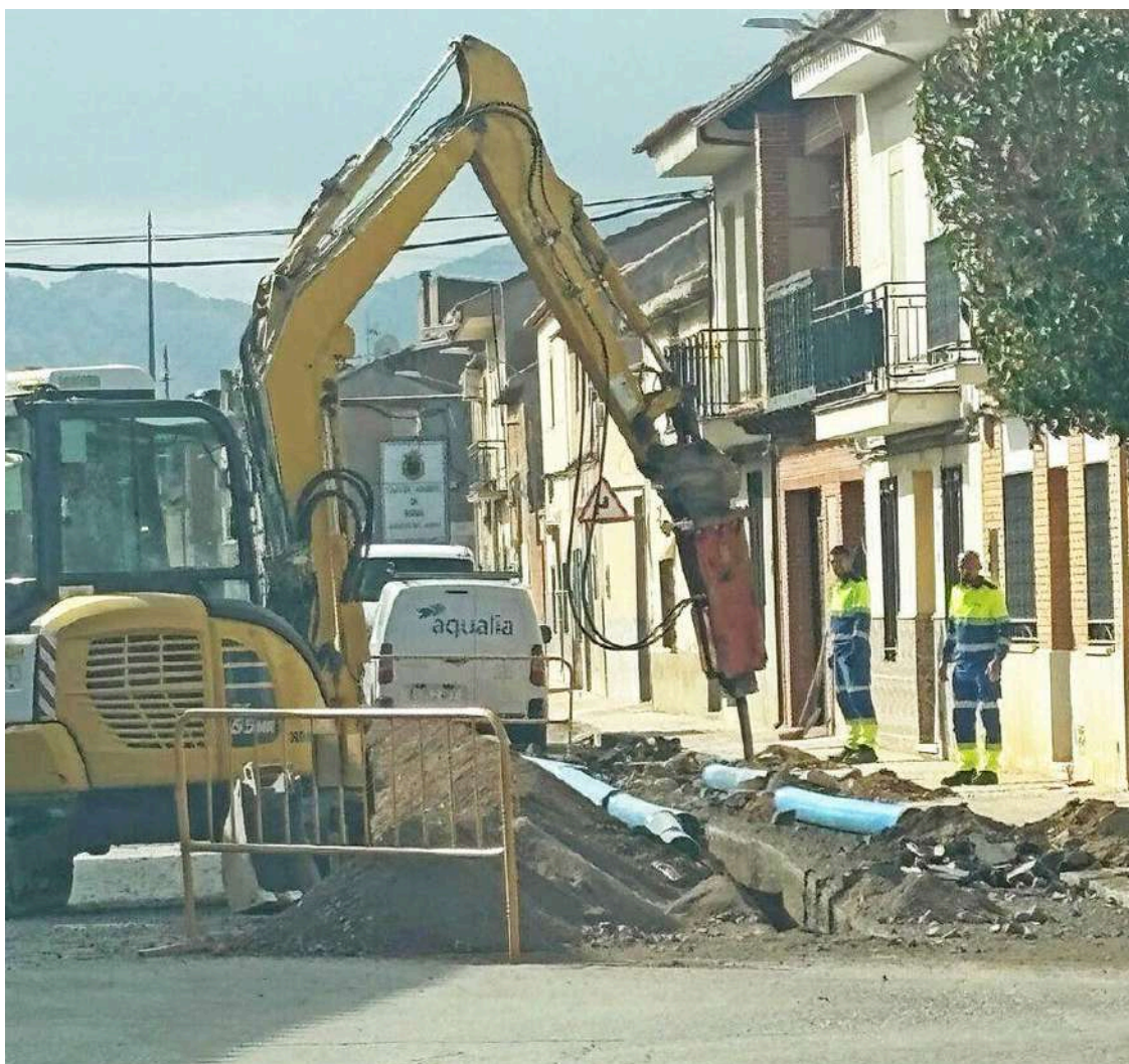
Aldea del Rey moderniza sus infraestructuras de agua potable
