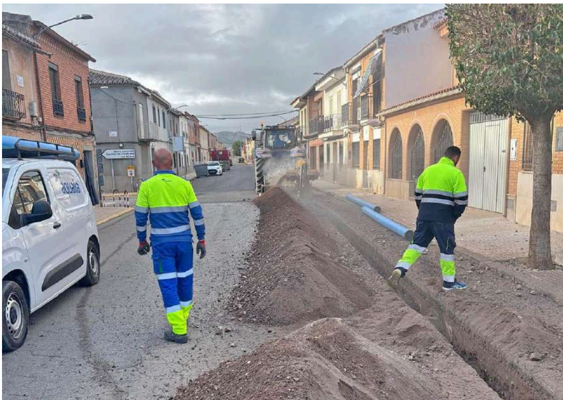
Imagen de las obras de renovación de las redes de agua potable en Aldea del Rey
