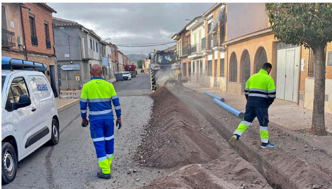
Comienzo de las obras de renovación de tuberías en la calle Rollo de Aldea del Rey / Lanza
