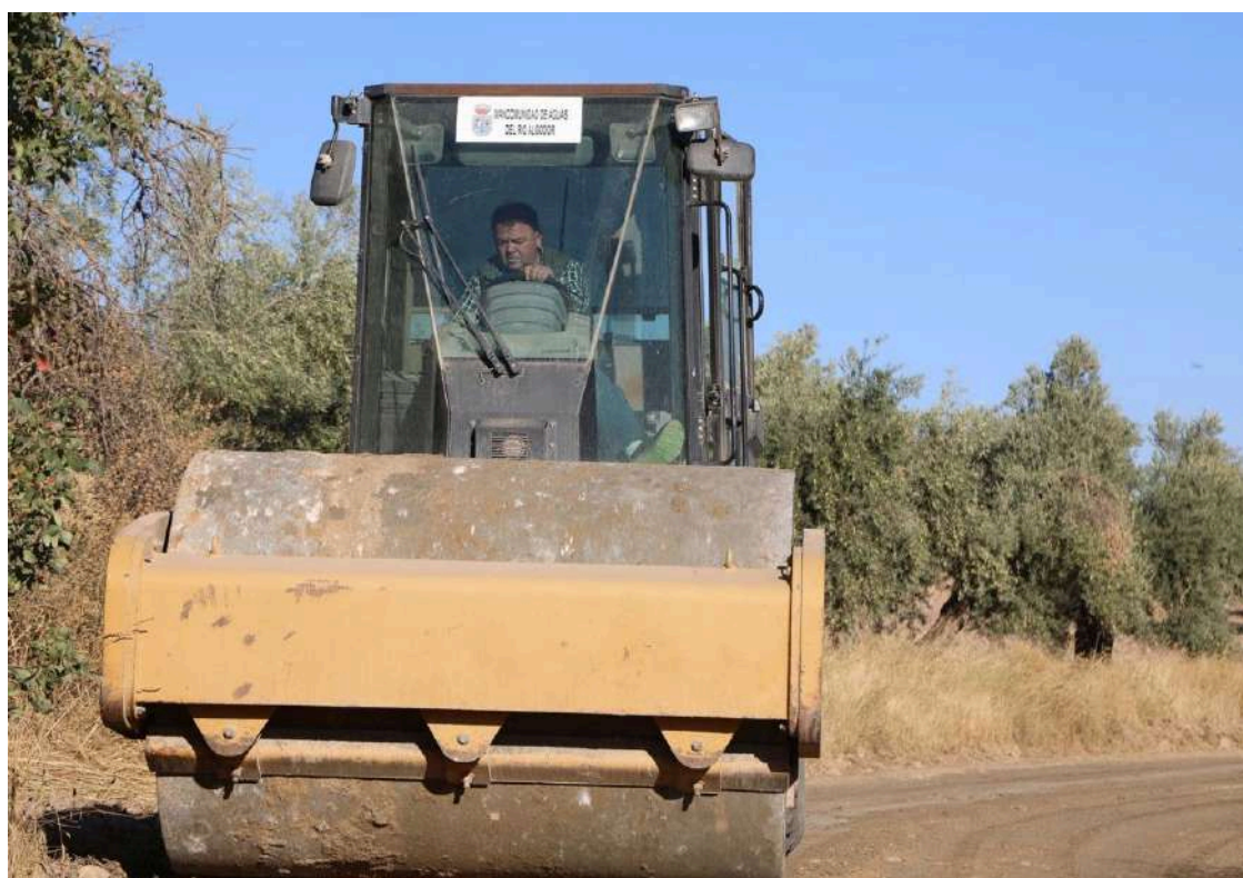
Intervención de la brigada de arreglo de caminos abc
